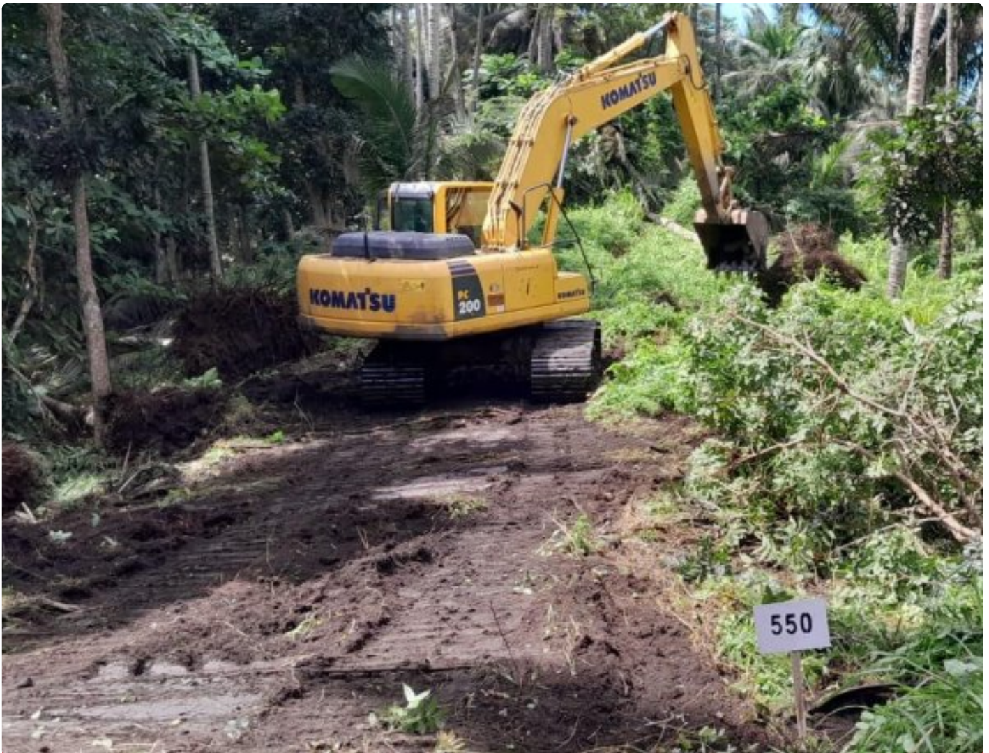
TMMD Ke-116, Pembukaan akses jalan industri Tani di Kelurahan Tandurusa
