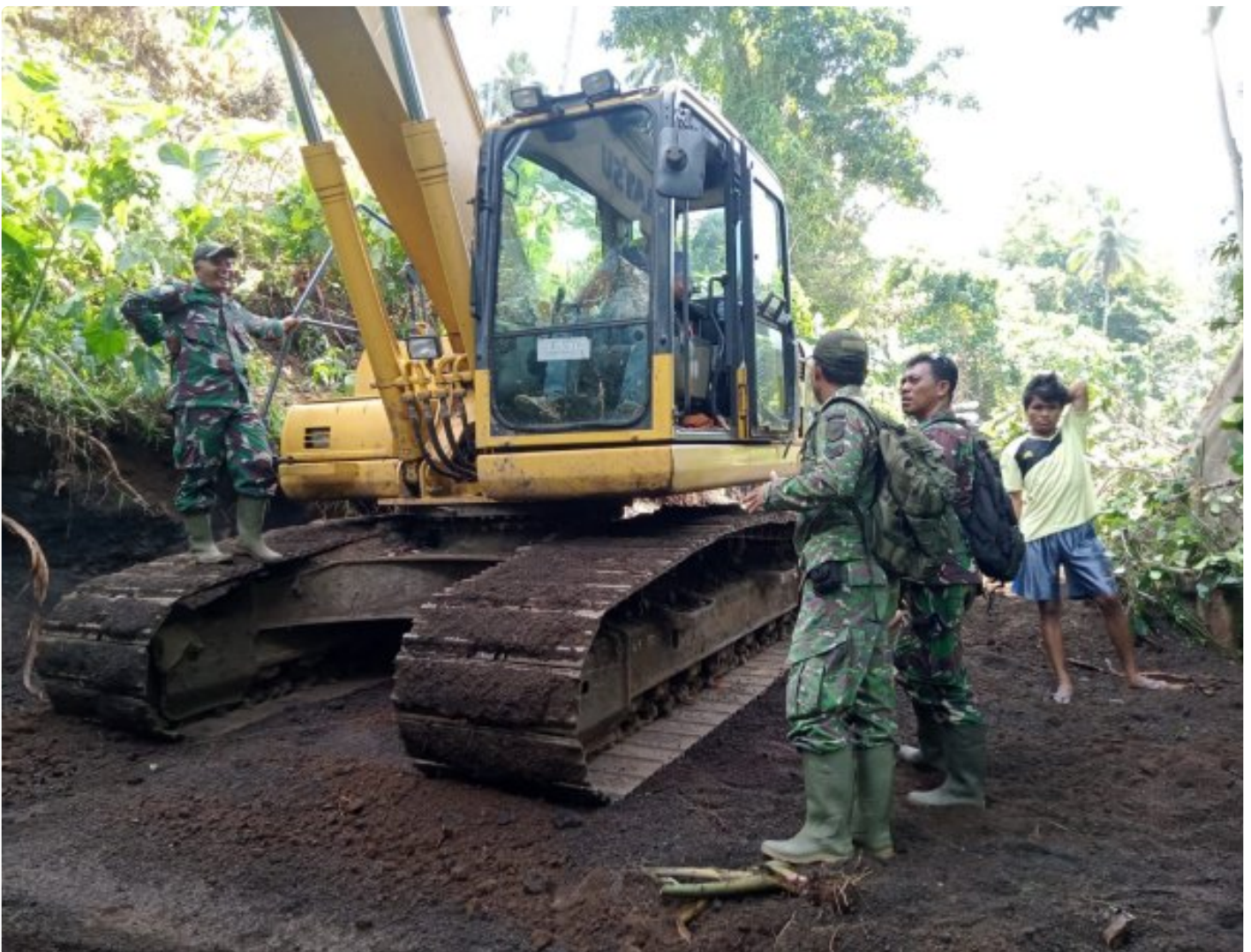
Ribtisan Jalan Pertanian pada TMMD Ke-116 Tahun 2023 Kodim 1310 Bitung
