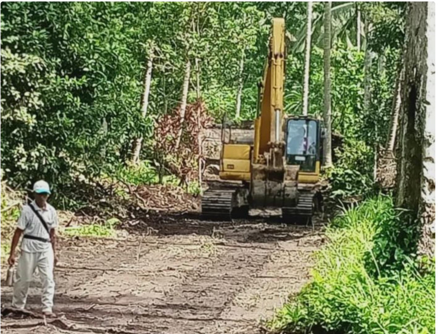
Pekerjaan Jalan Industri Pertanian pada TMMD Ke-116 di Kelurahan Tandurusa
