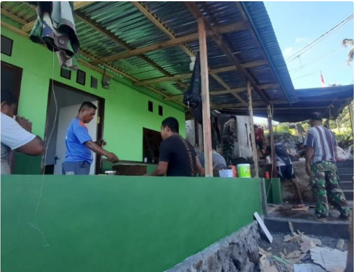
Pembangunan RTLH Keluarga Galvin Karaki pada TMMD Ke-116 Kodim 1310 Bitung
