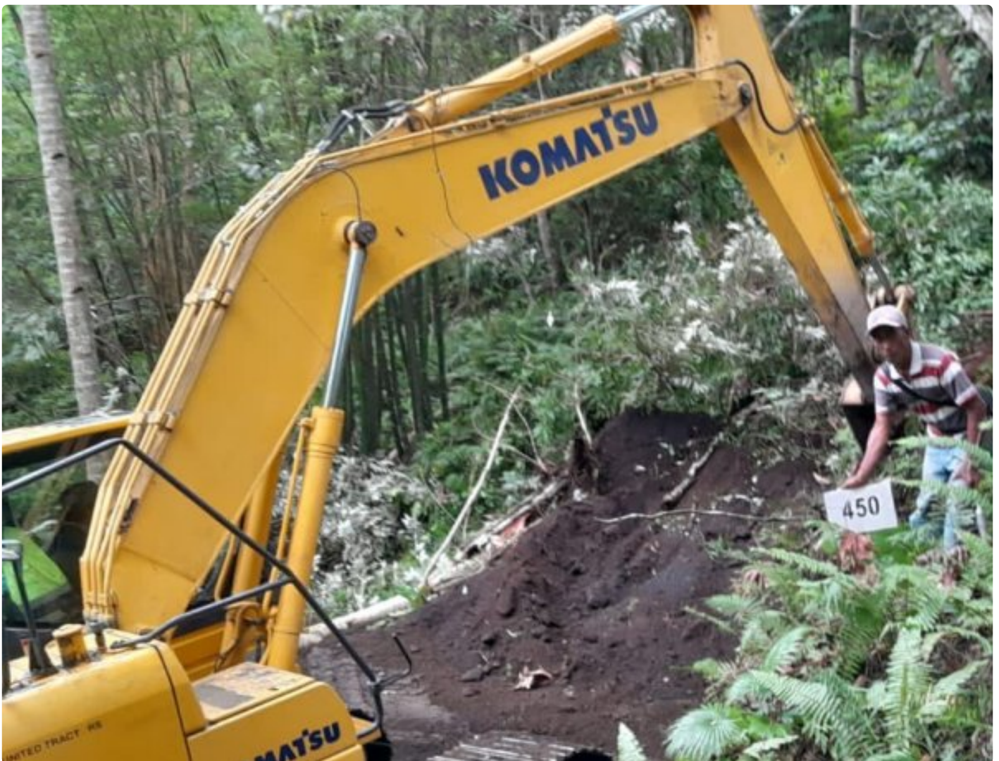
TMMMD Ke-116, Kebut Kerja pembuksan akses Jalan
