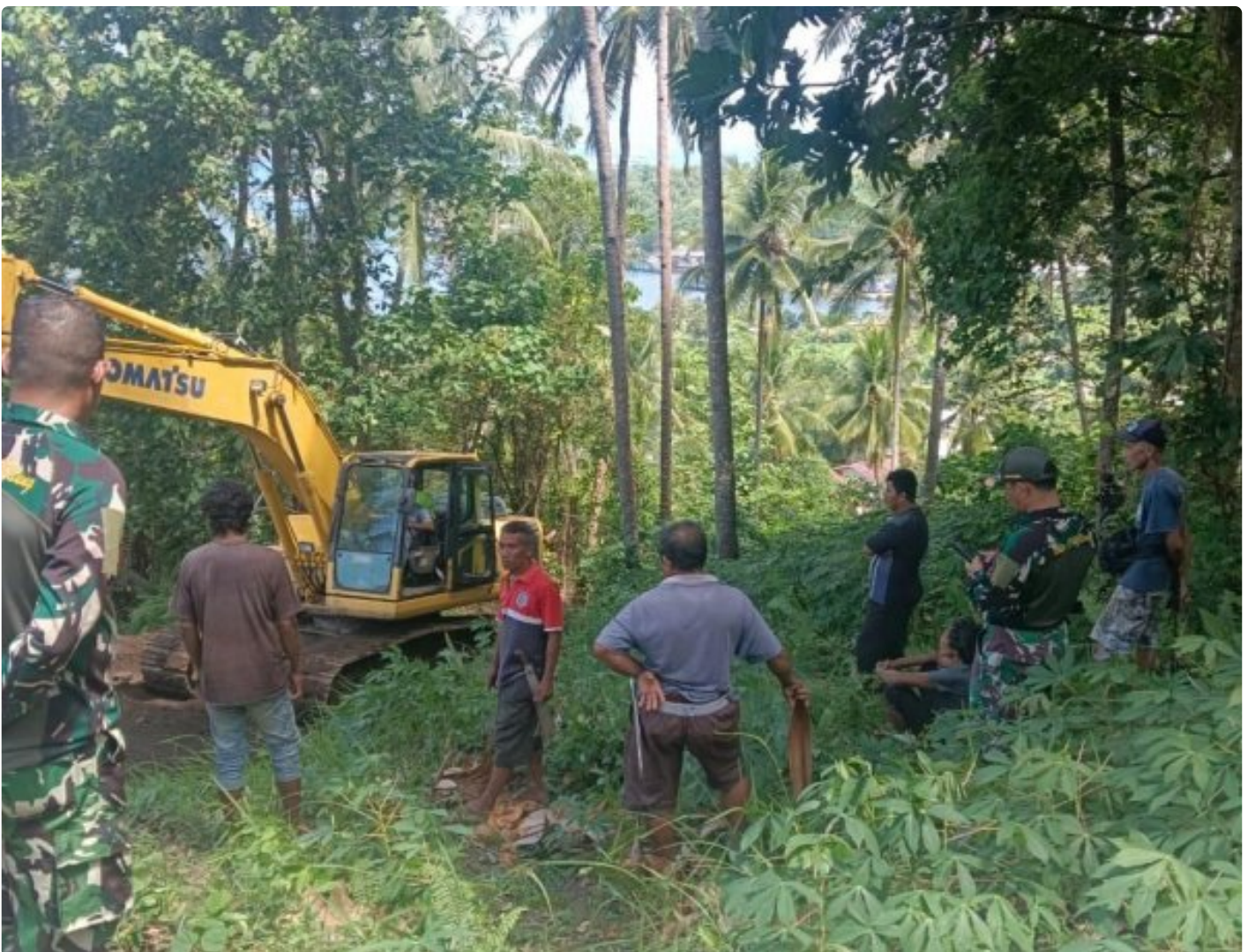
Dan Satgas TMMMD, Dandim Tinjau Pekerjaan Perntisan Jalan Pertanian
