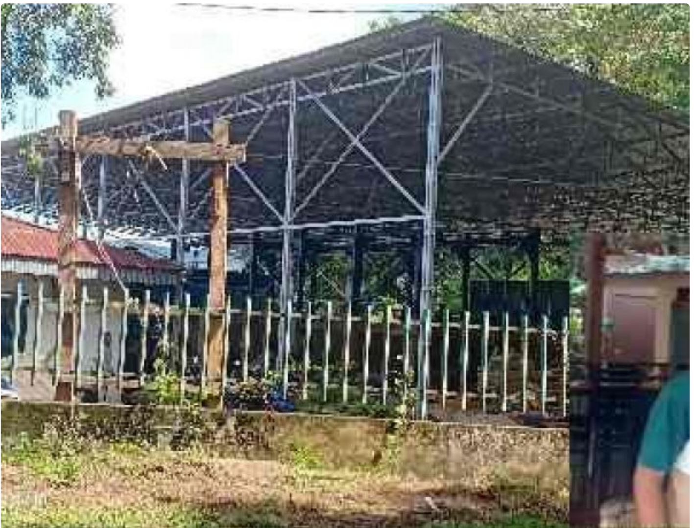
Kondisi Bangunan Pabrik Es di Kelurahan Tandurusa Tak miliki Ijin PBG
