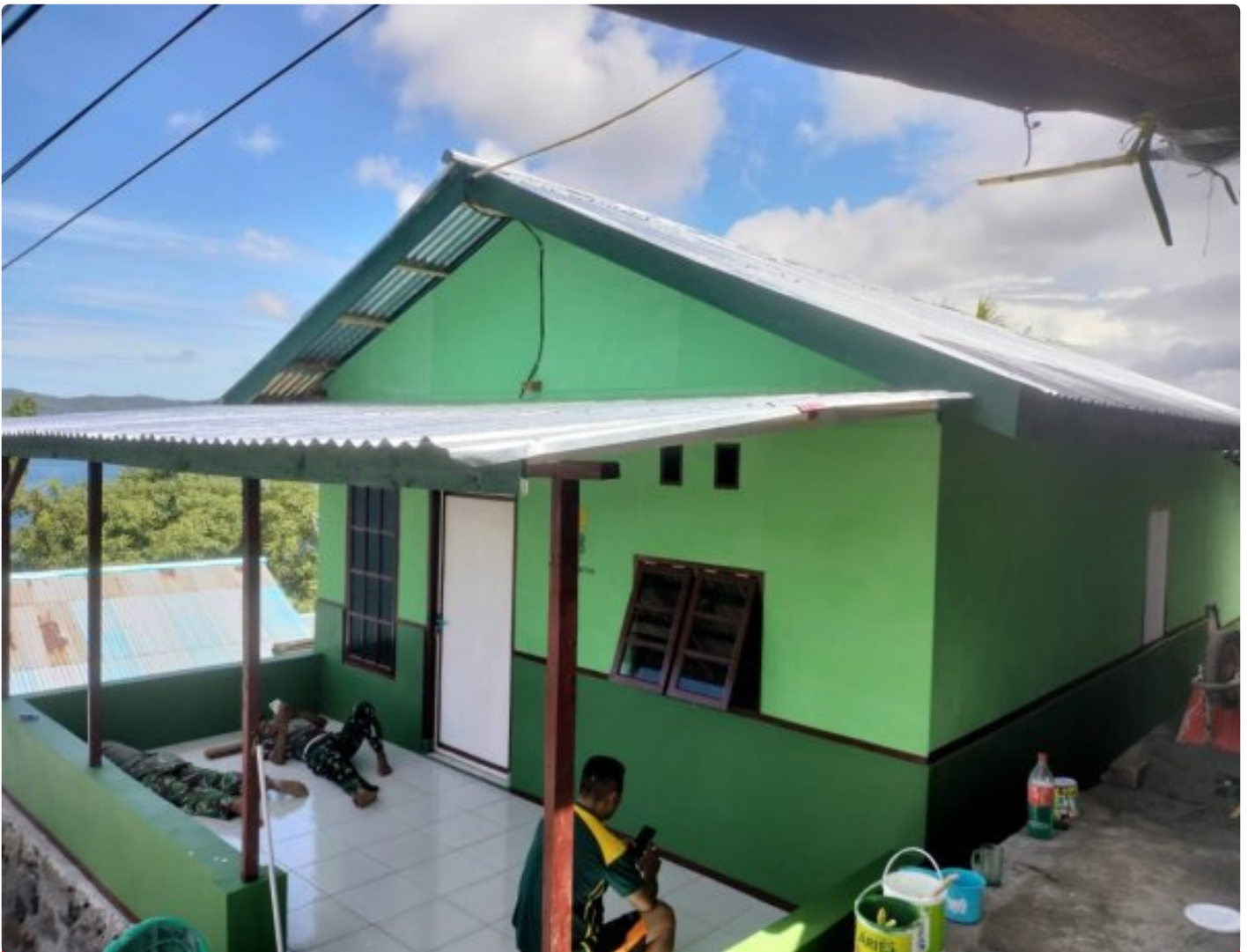
Renovasi RTLH TMMMD Ke-116 Kodim 1310 Bitung
